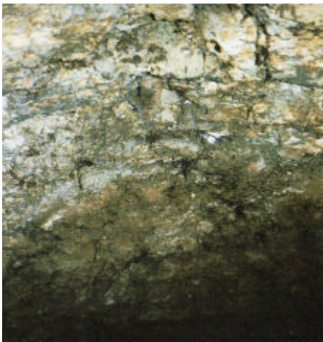
Wand der zylindrischen Mauer des Kalkofens in der Chalchtola, an dessen Wand sich die Glasur abgesetzt hatte.
